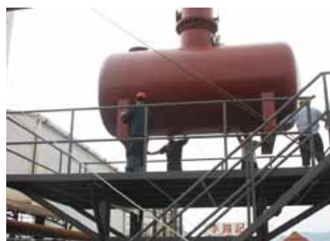
1. 1.2 台 10 吨环保锅炉 2. 锅炉配套设备安装
